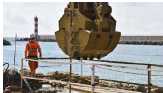
Aménagement du port de Port-la-Nouvelle
