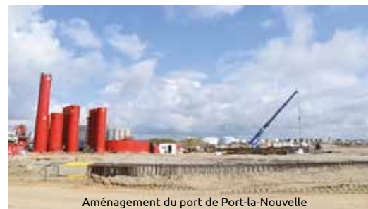
Aménagement du port de Port-la-Nouvelle
